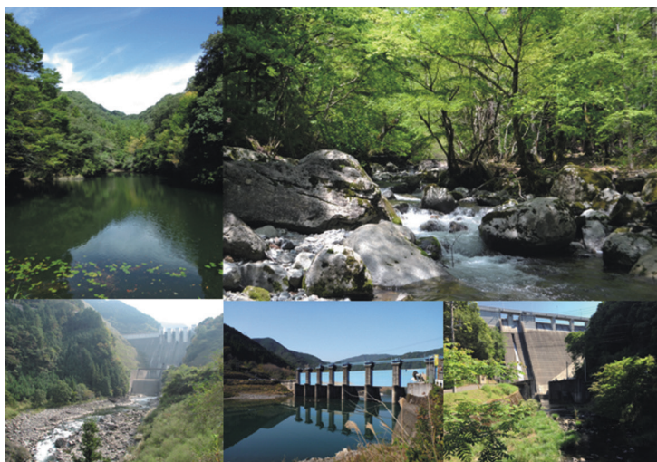
ため池、山地溪流、 富郷ダム下流、開放中のダムゲート、菅生ダム下流
