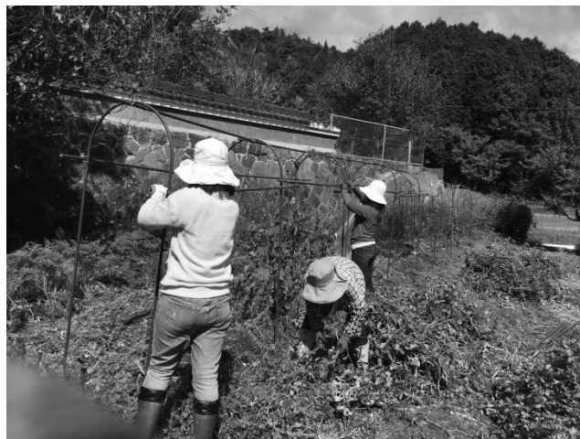
雨から守る屋根の組み立て。
