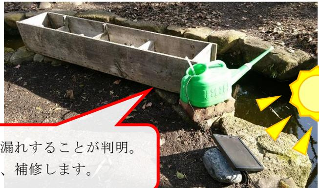
ソーラーパネルを使って水を汲み上げ、水漏れしないか確認。
