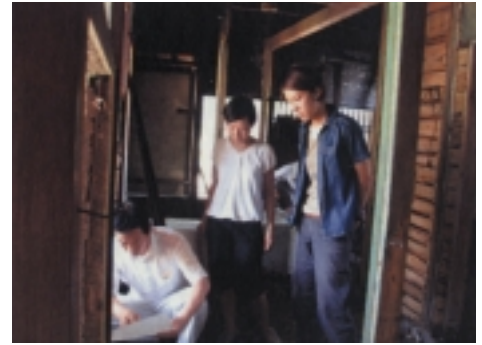
トイレ・浴室の改装
