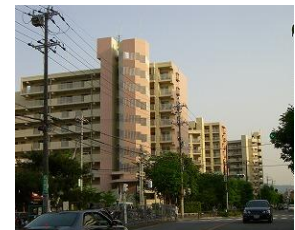
図9. 建替後の様子
