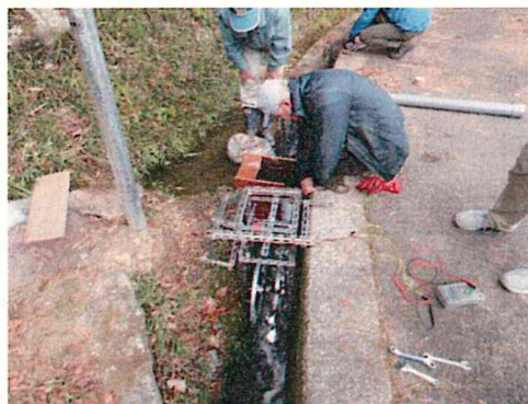
(b) 水車の設置
