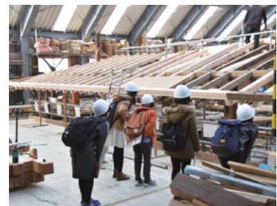
文化財の改修現場の見学
